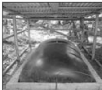
c) Sistema tubular con bolsa de polietileno - válvula en PVC
