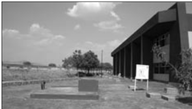
Foto 3.7. Captación de lluvia en la UTL.
