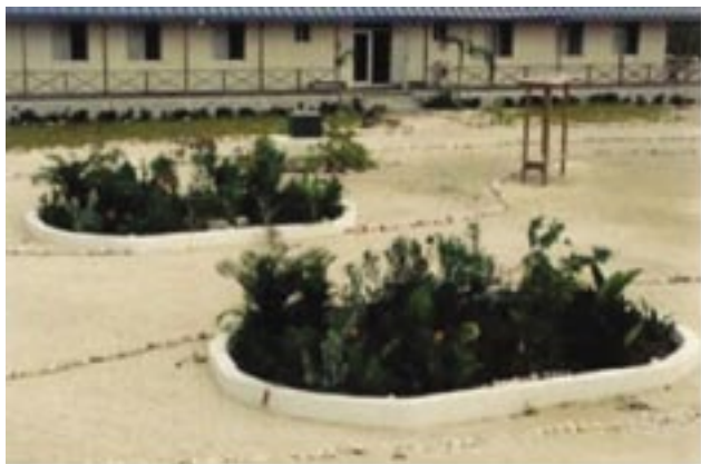
Humedales artificiales en una escuela
